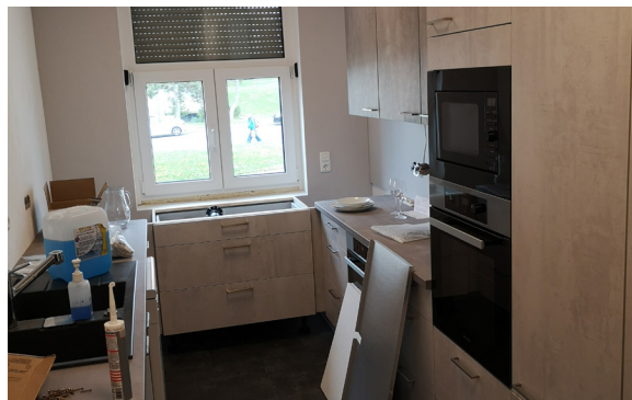
Die neue Küche der Bonhoeffergemeinde nimmt Gestalt an
